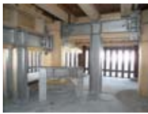
木造の五重塔の耐震補強
